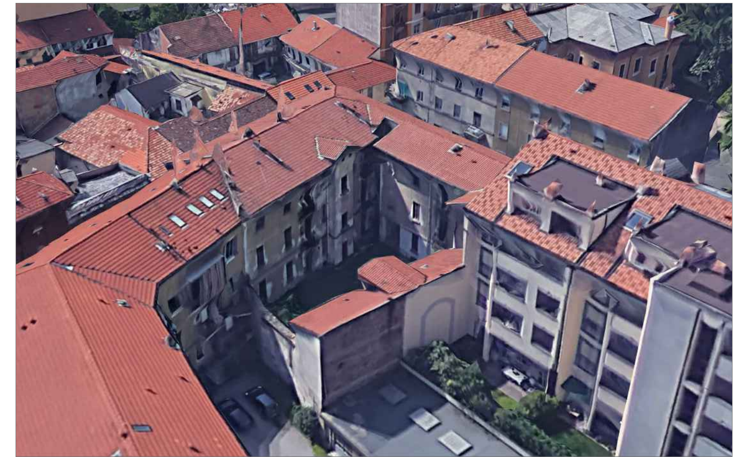
VISTA DEL CORTILE INTERNO
